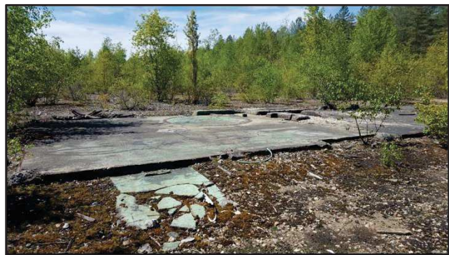
Dalle béton présente sur la zone 12 qui sera évacuée et traitée en site spécialisé
